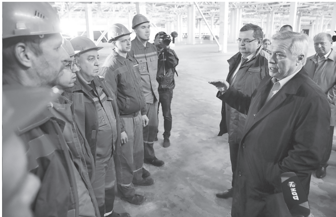
Один из первых цехов завода уже почти готов – там монтируют основное оборудование
